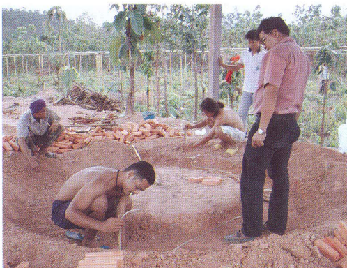
ภาพที่ 3 การวัดระดับฐานของเตาโดยใช้สายยาง (ระดับน้ำ)
