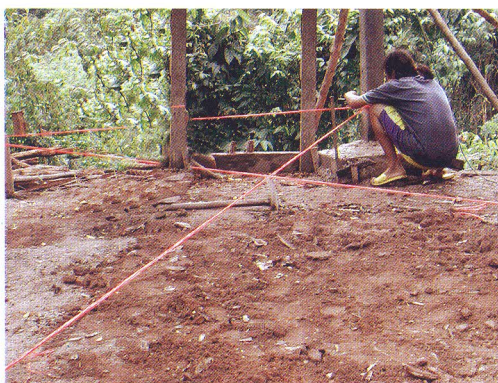
ภาพที่ 4 การวัดระดับฐานของเตาโดยใช้เชือก
