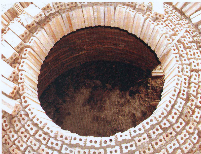
ภาพที่ 15 ลักษณะการเรียงอิฐด้านบนของเตา
