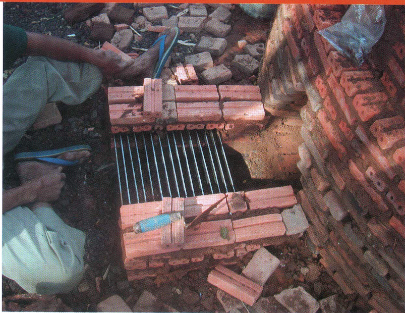
ภาพที่ 16 การเตรียมทำช่องใส่ไฟ
