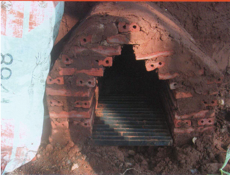
ภาพที่ 18 ช่องใส่ไฟพร้อมรังผึ้ง
